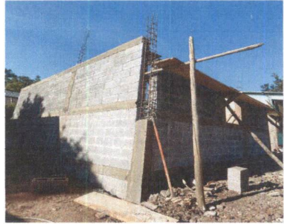
Foto 2: Área donde se contempla mejoramiento con estructura tipo pórtico e instalaciones de laminas troquelada calibre "26" en proceso a nivel de solera.
