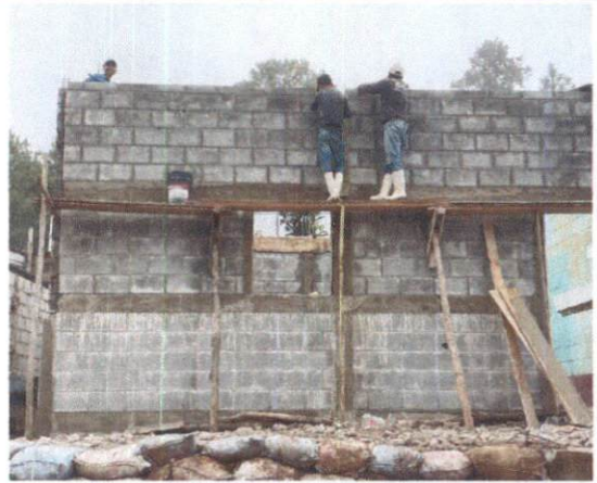
Foto 4: Área donde se contempla mejoramiento con estructura tipo pórtico e instalaciones de laminas troquelada calibre "26" en proceso a altura de entechado.
