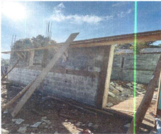
Foto 3: Área donde se contempla mejoramiento con estructura tipo pórtico e instalaciones de laminas troquelada calibre "26" en proceso.
